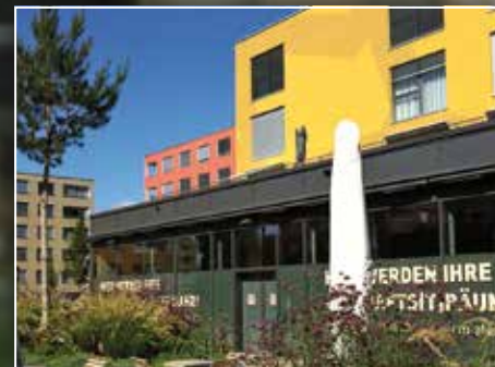
Lyssbachpark, Lyss – Entwicklung und Projektleitung in allen Phasen bei IttenBrechtbühl. Das einzige Vorstadtzentrum im Kanton Bern, in dem Menschen wohnen, arbeiten und einkaufen. Der Lyssbachpark spielt mit dem Kontrast zwischen Urbanität und Natur.
