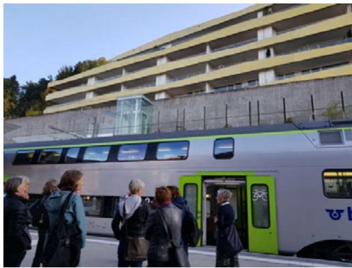
BLS-Station Wabern, hinten Stützmauer / Einstellhalle und Wohngebäude "Quellfrisch"
