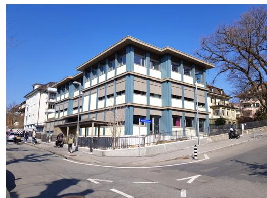
Ausser dem Erschliessungskern und dem Keller handelt es sich um einen Holzbau. Durch die etwas komplizierte Fassadenabwicklung und -konstruktion geht etwas an typologisch erwünschter Eleganz verloren.
