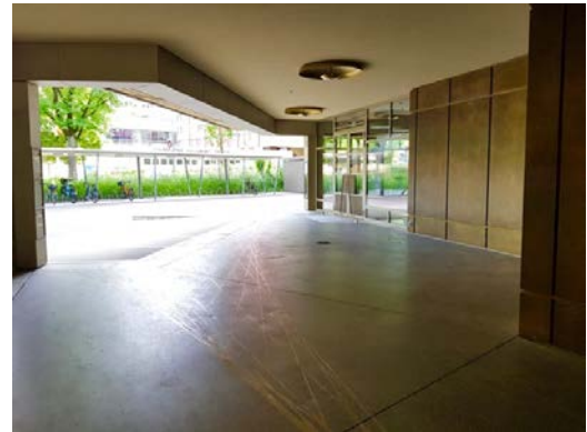
Zwischenraum Blick Richtung Strassenseite
