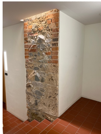
Tuff gegen aufsteigendes Wasser
