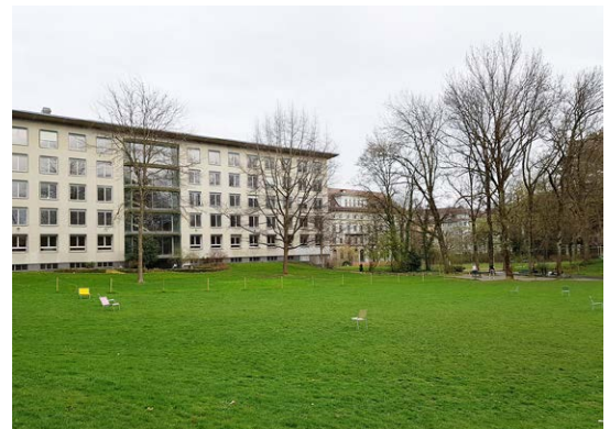
Monbijoupark mit Wassertanks unter der Erde
